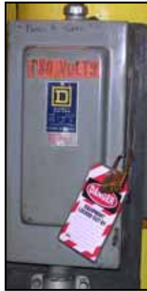
Figura 3-2: Bloqueo/Etiquetado del panel de fuente de alimentación
